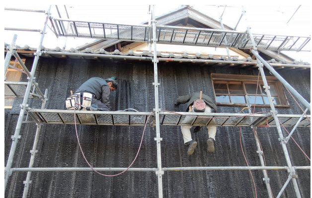
外壁焼板張り（大工による）
